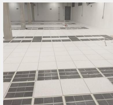
Os pisos elevados são uma solução moderna e versátil, especialmente adequada para ambientes comerciais, industriais e corporativos. Esses sistemas consistem em painéis modulares apoiados em pedestais reguláveis, permitindo a criação de um espaço vazio sob o piso, que pode ser utilizado para a passagem de cabos, dutos de ar condicionado, redes de dados e outras infraestruturas essenciais.
